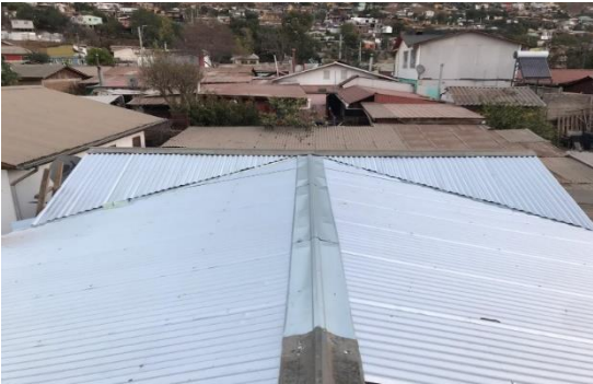
PROYECTO MEJORAMIENTO TECHUMBRE EJECUTADO EN CABILDO SECTOR URBANO
