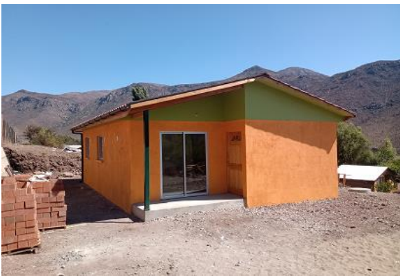
PROYECTO VIVIENDA NUEVA UBICADO EN LA LOCALIDAD DE ALICAHUE
