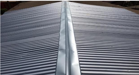
PROYECTO MEJORAMIENTO TECHUMBRE EJECUTADO EN CABILDO SECTOR URBANO
