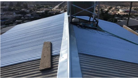
PROYECTO MEJORAMIENTO TECHUMBRE EJECUTADO EN CABILDO SECTOR URBANO
