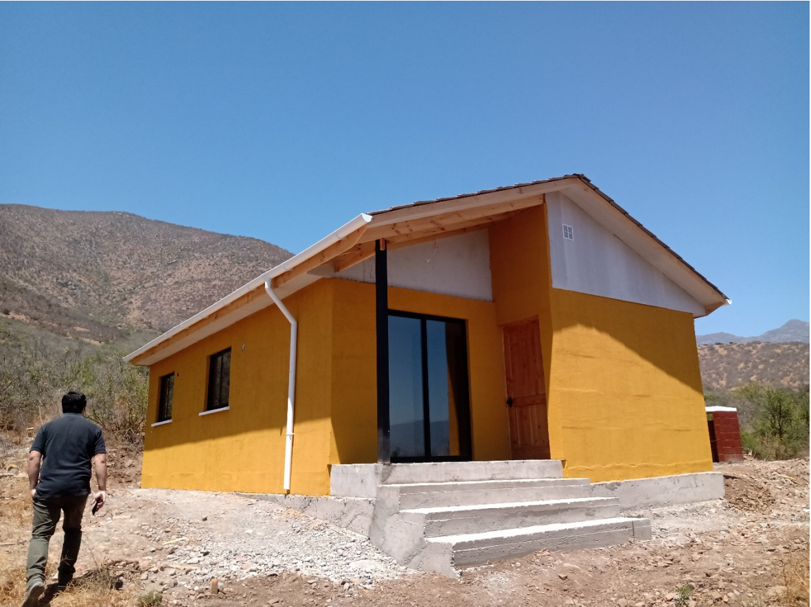
Imagen: Avance de obra de un 80% de ejecución de la vivienda.
